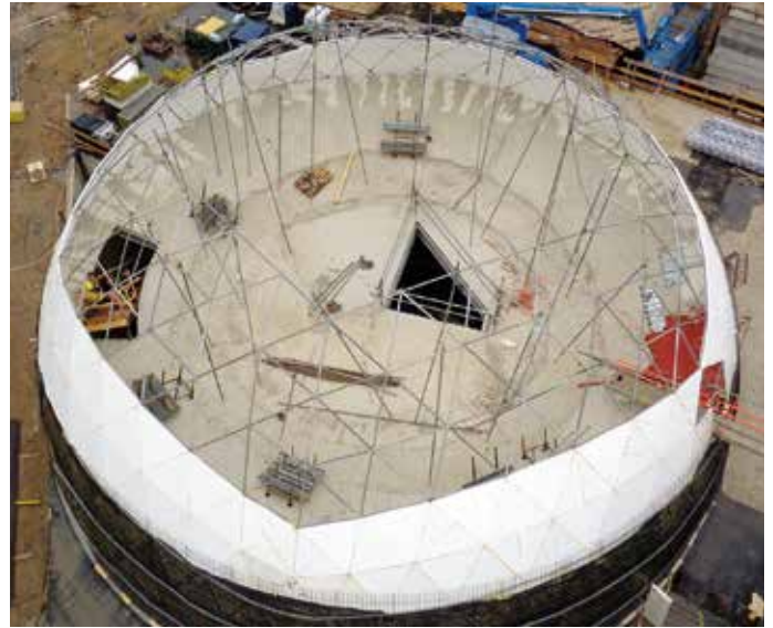
Bekisting met steigerbuizen. De geodetische koepel is reeds deels ingevuld met eps-blokken.
