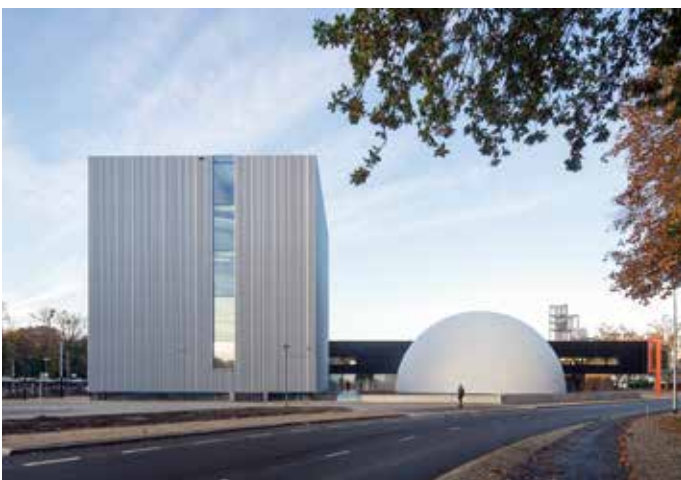
Links Cube. De gevel is uitgevoerd in gezette staalplaat.
