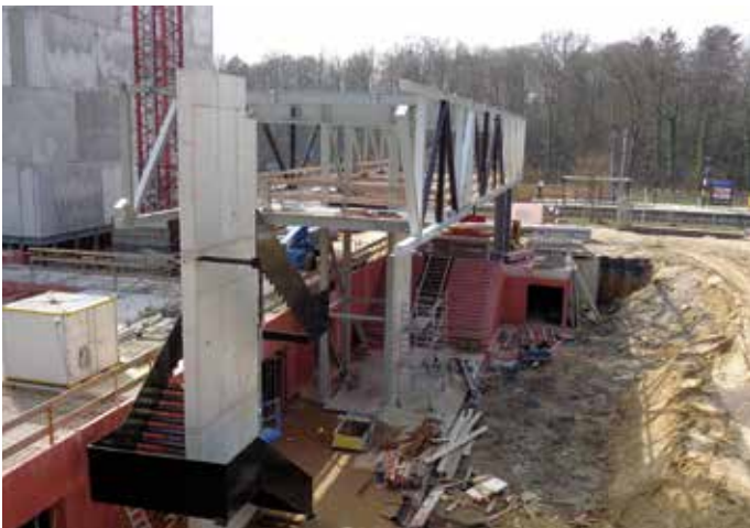
Connector in aanbouw. Voor bouwsnelheid is de trap al aangebracht.
